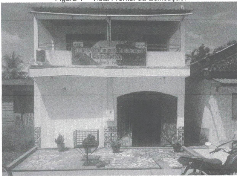
Figura 1 – Vista Frontal da Edificação.
